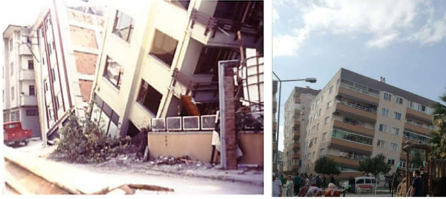
Şekil 5.9 1999 Kocaeli depreminden sonra Adapazarı'nda sıvılaşma kaynaklı taşıma kapasitesi yenilmesi (solda) ve İzmir-Seferihisar açıkları (Sisam) depreminden sonra giriş kat kolonlarının ve perde duvarlarının kısmi yenilmesi sebebiyle yan yatan binalar (sağdaki resim: 38.461689, 27.180669).
