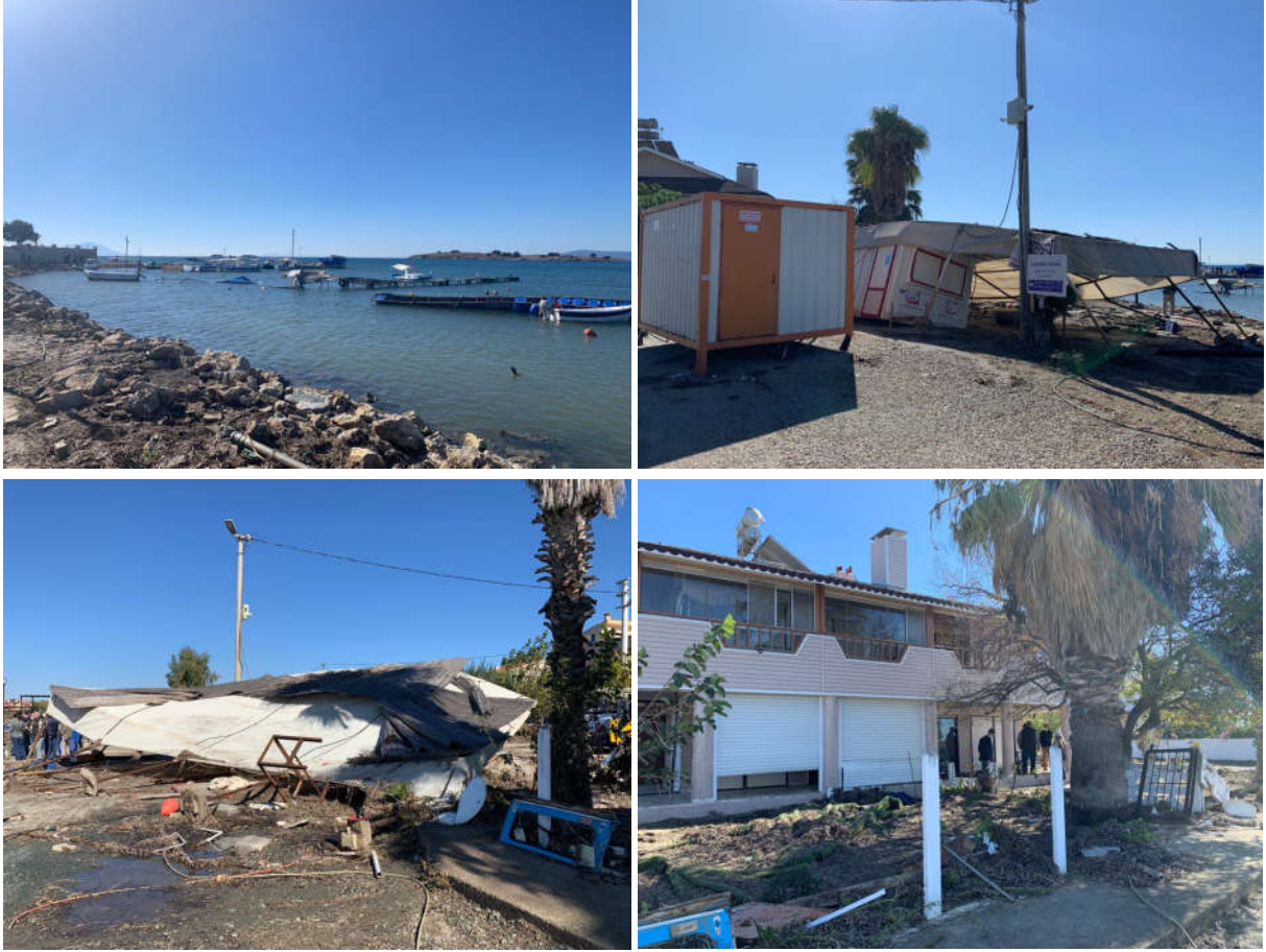
Şekil 4.6 Akarca’da tsunami nedeniyle hasar gören balıkçı barınağı iskelesi, tekneler ve küçük yapılar
